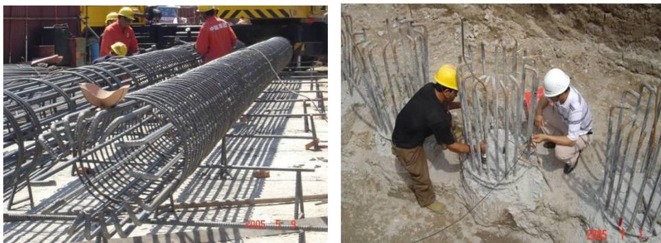
图 5.3.5-3 钻孔灌注桩施工
