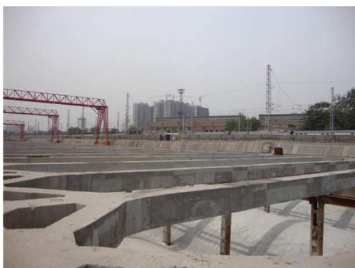
图 5.3.5-6 钢筋混凝土支撑
