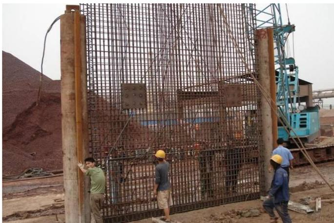
图 5.3.5-5 地下连续墙施工
