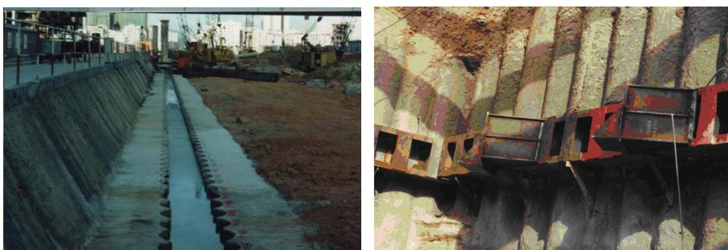
图 5.3.5-4 钻孔咬合桩施工
