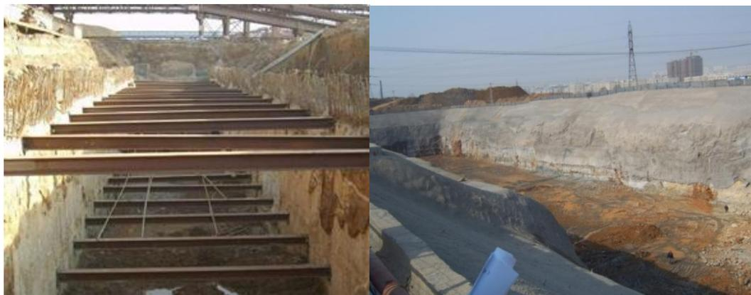
图 5.3.5-1 明挖法施工现场图
